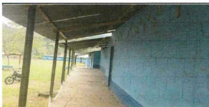
Foto 6: En esta fotografia se puede apreciar la cubierta de lámina en mal estado.
